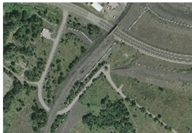
Obrázek 12: Železniční násyp na snímku z roku 2003.
